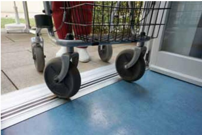
*Dank dem barrierefreien Renovierungsprofil der Magnet-Doppeldichtung können 1 – 2 cm hohe Türschwellen im Bestand abgebaut werden, ohne dass aufwendige Abrissarbeiten im Fußbodenbereich notwendig werden.*
