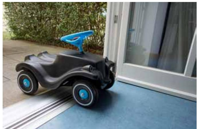
*Mit dem Renovierungsprofil der barrierefreien Magnet-Doppeldichtung ist selbst im Altbau ein sturzpräventiver Nullschwellen-Übergang möglich. Die aktuellen U-Werte dieser Dichtung übertreffen die technischen Mindestanforderungen der KFW bezüglich des energieeffizienten Sanierens zusätzlich.*
