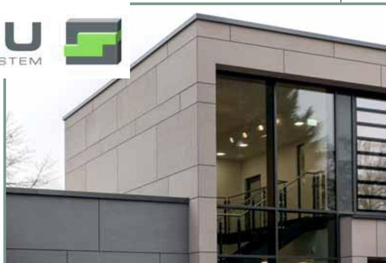
Verglasung der Fenster im Erdgeschoss ist in P4A ausgeführt, im OG und Treppenhaus wurden Lamellenfenster sowohl zur Be- und Entlüftung als auch zur Entrauchung vorgesehen. Alle Fensterflügel verfügen über Magnetkontakte. Für den außenliegenden Sonnenschutz als Wärme-, Licht- und Blendschutz im Bereich Büro und Besprechung wurden randgebördelte Lamellen mit hoher Stabilität und geringer Geräuschentwicklung mit Motorantrieb gewählt.
