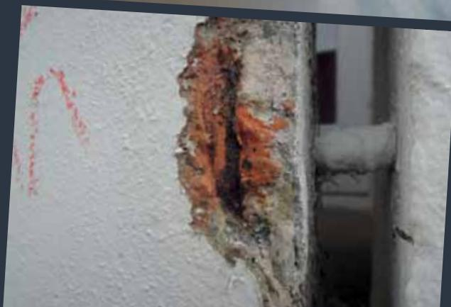
platzungen waren jedoch im Bereich der vorhergegangenen Instandsetzung und deren Nachbarbereichen, sowie im Bereich der Horizontalanker aufgetreten.
