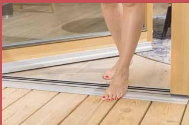
Die schwellenfreie Magnet-Doppeldichtung bietet für alle eine sichere Nutzbarkeit, eine bessere Ergonomie, eine optimale Sturzprävention, eine echte Barrierefreiheit, ein gutes Design und eine langzeiterprobte Abdichtungstechnik.
