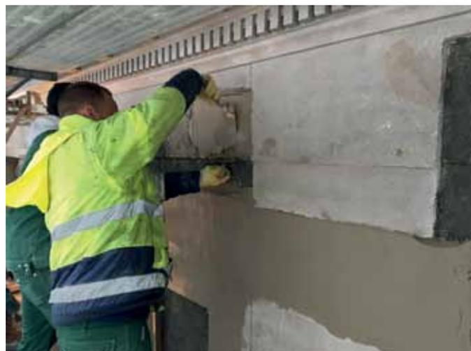
Auftrag des Remmers Restauriermörtels an der Sandsteinfassade.
