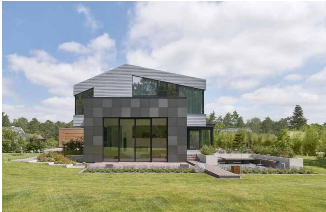
rasse hinaus führt. Die Architektin wählte bewusst eine Pfosten-Riegel-Konstruktion in Stahl-Profilbauweise, da nur auf diese Weise die gewünschten, von Querriegeln freien Feldabmessungen realisierbar waren.
