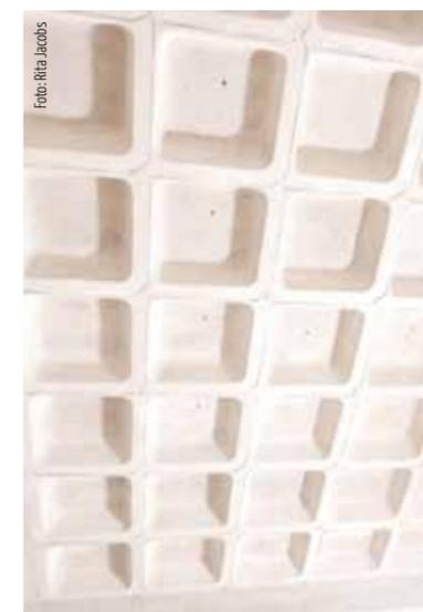
Kleinteilige Instandsetzung der Kasettendecke im Untergeschoss der Neuen Nationalgalerie. Links die fertiggestellte Fläche.
