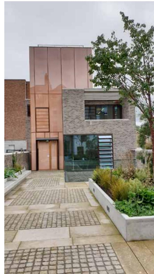
drahtgewebeeinlage. Der Vorteil dieser Einlage ist neben dem optischen Aspekt, dass die Fenster über einen zusätzlichen Blick- und Sonnenschutz verfügen.
