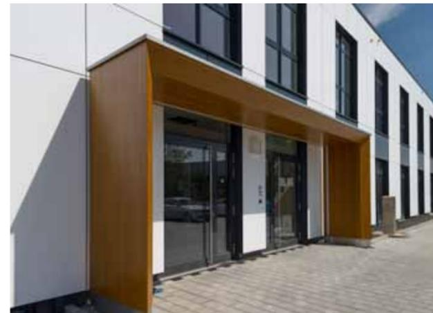
Für die Verkleidung des Gebäudes haben die Planer metallisch anmutende HPL-Fassadenplatten (High Pressure Laminate) ausgewählt. Die Holz-Portale in geölter Eiche stehen zu der technisch anmutenden Gebäudehülle in reizvollem Kontrast.
