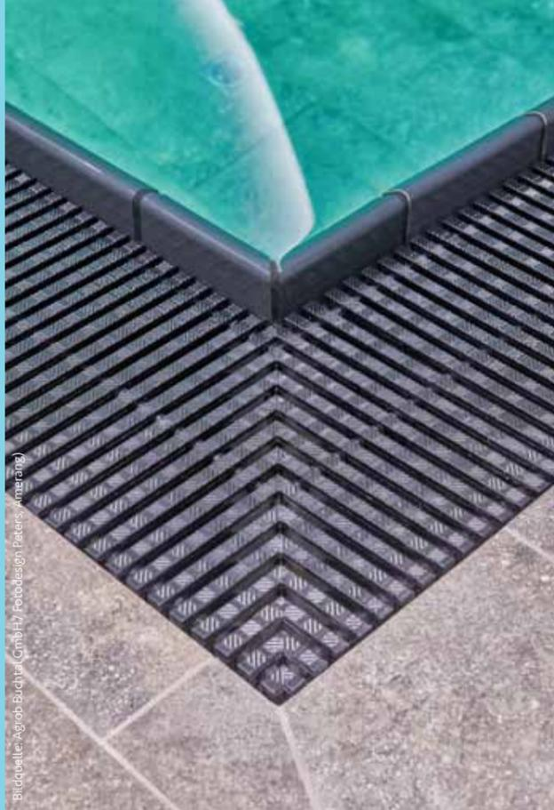
Das Beckenrandsystem Wiesbaden wurde speziell für dieses Projekt mit abgeschrägter Handfasse, einer Ausklinkung und in Sonderfarbe Schwarz von Agrob Buchtal gefertigt. Der farblich korrespondierende Rost ist ebenfalls eine Individuallösung, um so die Silhouette des Pools markant zu illustrieren
