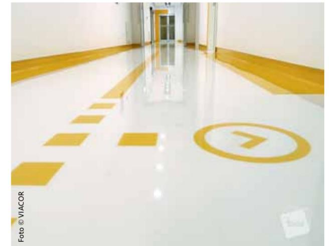
Zur Vermeidung von Explosionen, muss der Boden im Sauerstoff-Lagerraum ableitfähig sein. Zum Einsatz kam das leitfähige Bodensystem VIASOL UNIVERSAL voltex – ein vierschichtiges Epoxidharzsystem mit dem ableitfähigen Oberbelag VIASOL EP-C540AS und einer Leitschicht.
