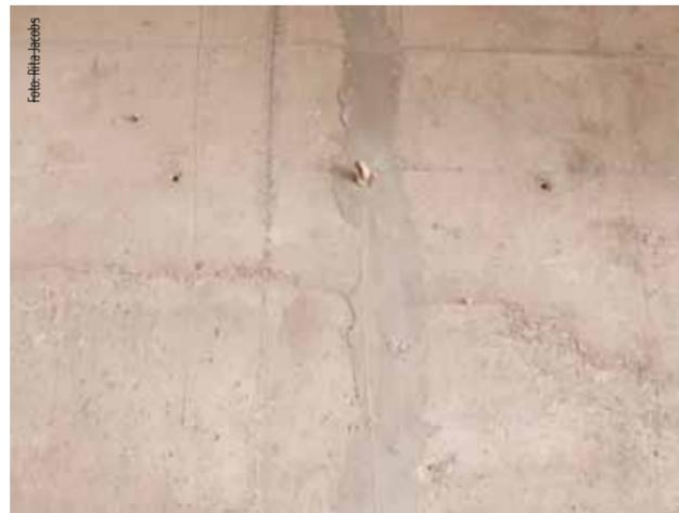
Instandgesetzte Risse im Untergeschoss der Neuen Nationalgalerie. Sie wurden in Abhängigkeit von der Rissbreite mit Zementsuspension oder Zementleim verpresst. Bauseits vorgeschrieben waren Rissfüllstoffe, die gemäß EN 1504-5 hergestellt wurden.
