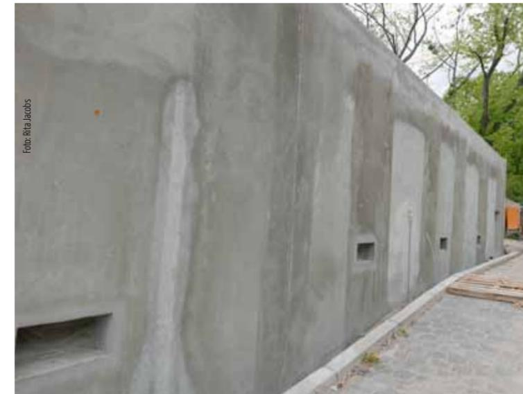
Auf den Flächen der Betonwände der rückwärtigen Rampe wurde der schadhafte Beton großflächig abgetragen, eine neue Bewehrung eingebaut und eine neue Betondeckung aufgebracht.
