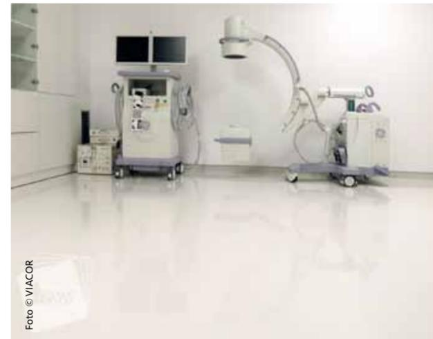
applizierte TTB Tenzo ebenfalls mit VIASOL PU-C525 eine weiße, trittschallreduzierende Verlaufsbeschichtung.
