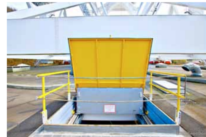
Diese Klappe trennt den unterirdischen Werkstatt- und Lagerbereich vom Außenbereich und ermöglicht somit den Transport größerer Lasten über eine Deckenöffnung.
