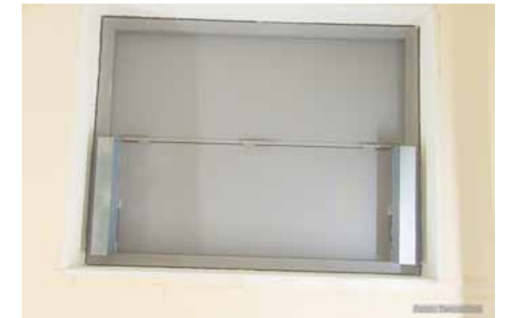
Um diese Dimensionen zu erreichen, entwickelte System Schröders eine zweiflügelige, feuerhemmende Faltschiebeklappe, deren Flügel sich über ein Rollensystem in eine Richtung auffalten.
