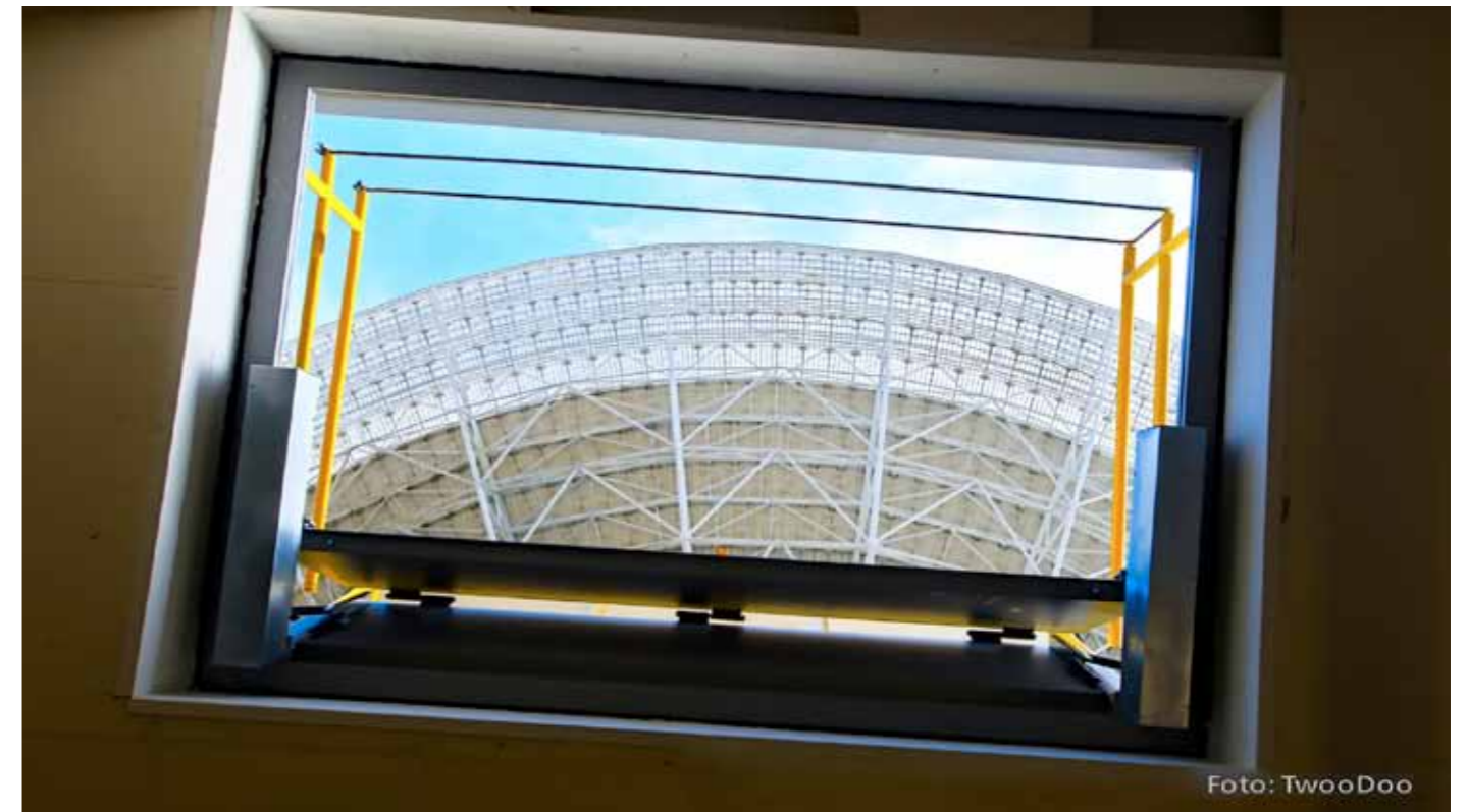
Damit die Öffnung groß genug ausfällt, musste die Feuerschutzklappe in einer Sonderkonstruktion mit den Maßen 1,80 x 2,40 Metern konstruiert werden.
