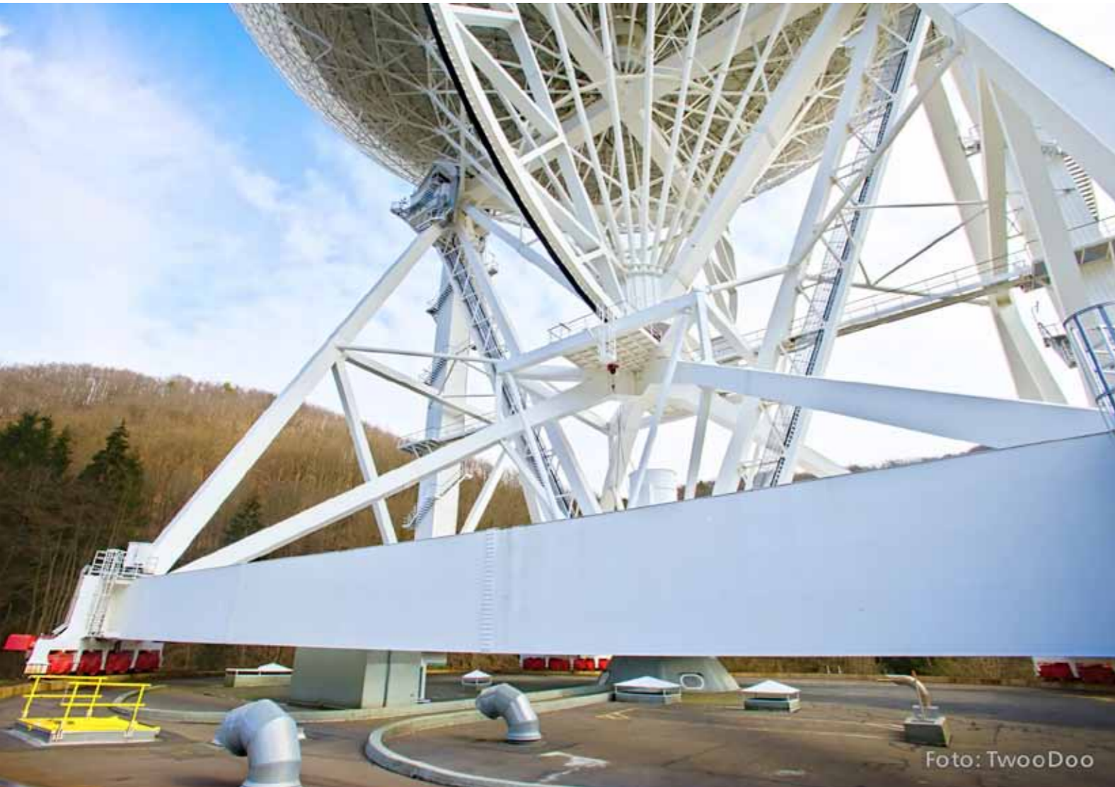
Die T30 Feuerschutzklappe „System Schröders“, ist unterhalb des Teleskops in dessen Drehbereich verbaut
