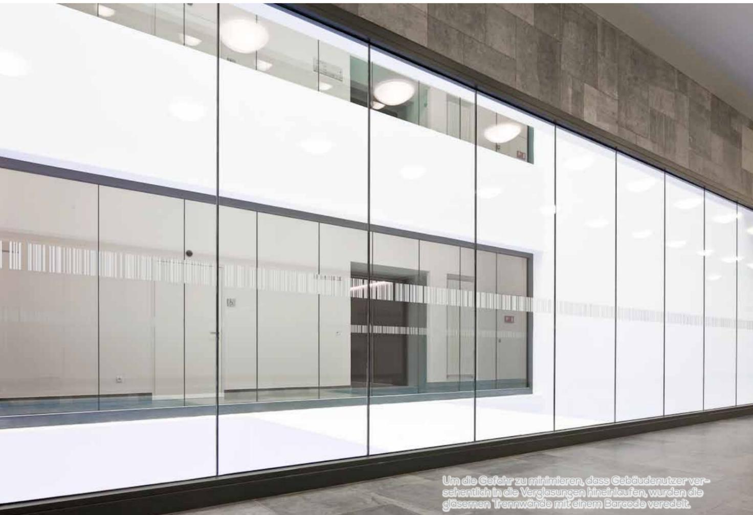
Um die Gefahr zu minimieren, dass Gebäudenutzer versehentlich in die Verglasungen hineinflüchten, wurden die gläsernen Trennwände mit einem Barcode veredelt.
