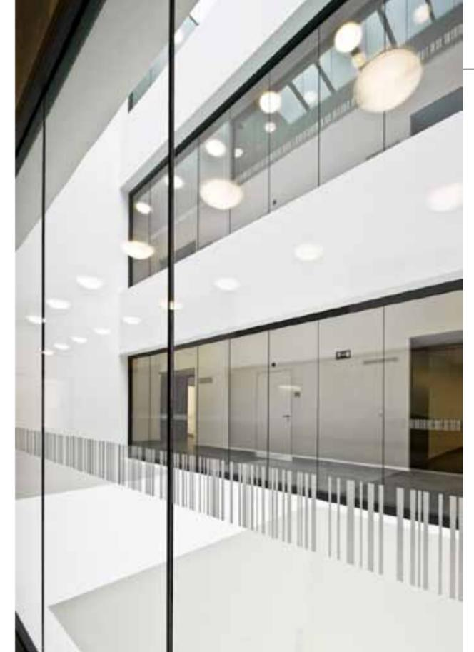
Edel, transparent, praktisch: Die saubere Verbindung der einzelnen Verglasungselemente erzeugt ästhetische Glasoberflächen, die leichter zu reinigen sind – entsprechend der hohen Hygieneanforderungen, die besonders in Kliniken zum Tragen kommen.
